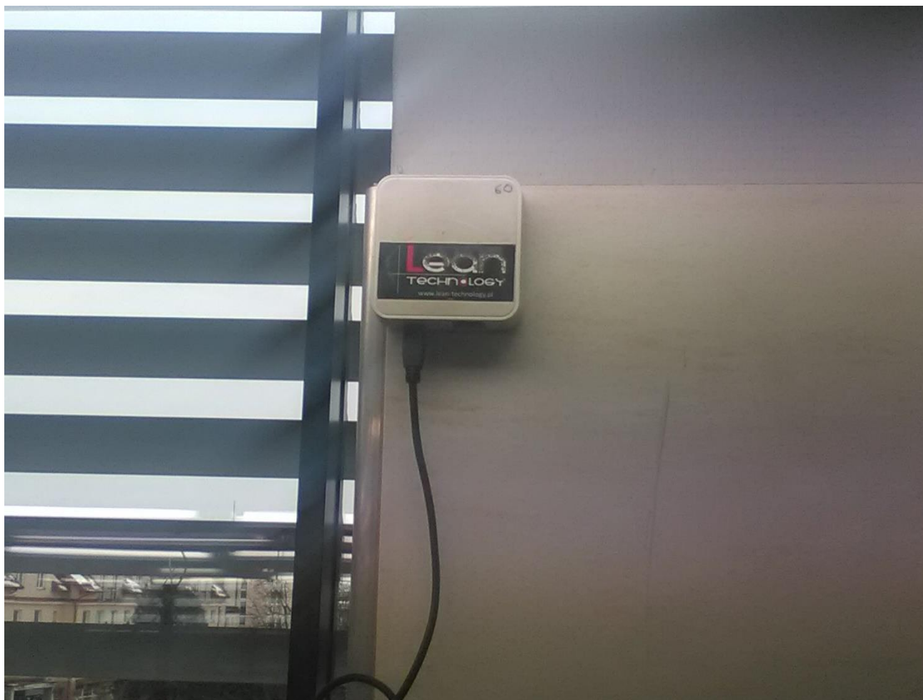
Jedna z zamontowanych na hali produkcyjnej anten odbiorczych.
